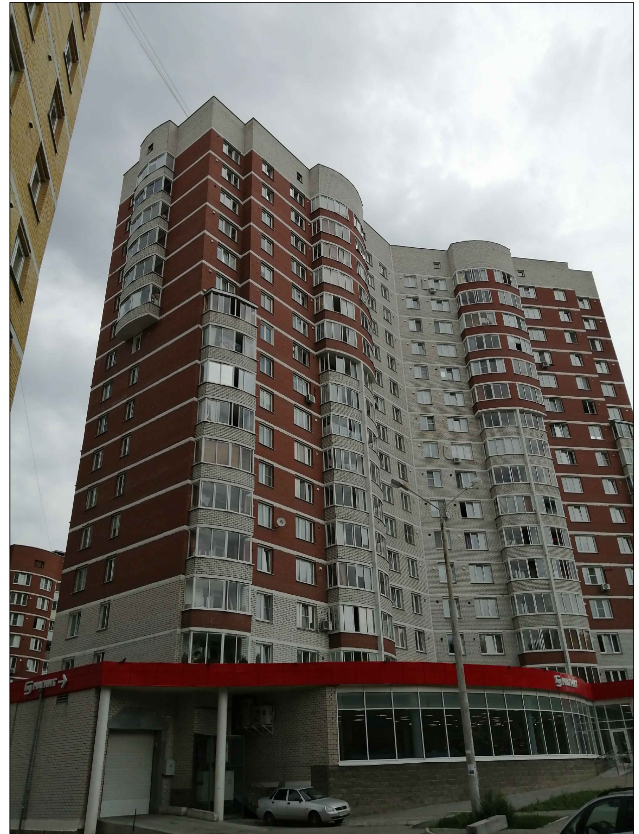
6. Фасад по ул. Южногорская
